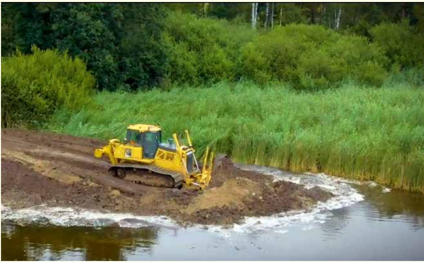
Graafwerkzaamheden tijdens het natuurherstelproject.
