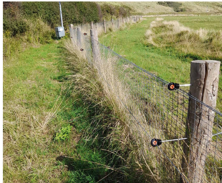
Figuur 31. Nieuw aangelegd raster met draden op spanning, één halverwege het hek en iets naar buiten geplaatst, één topdraad en nog een draad aan de binnenzijde. Het gaas is hier zeker 15cm de grond in gegraven, om te voorkomen dat vossen er onderdoor kunnen. Noordervron.
