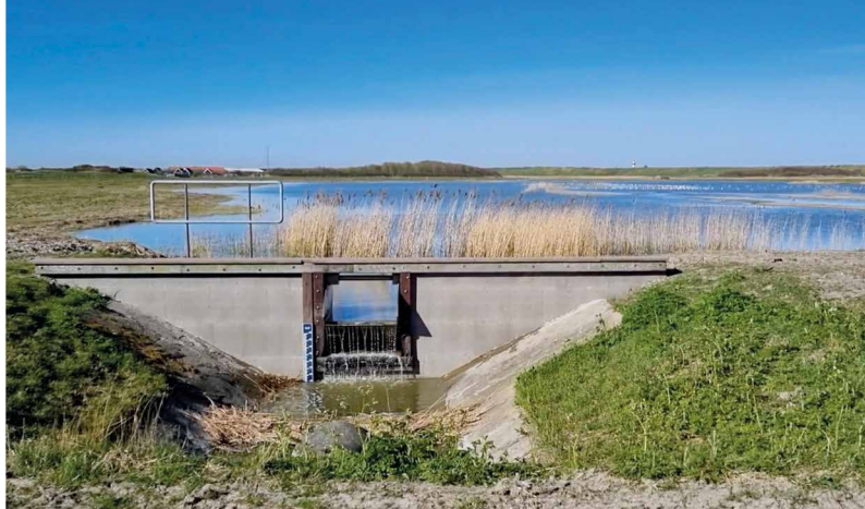
Figuur 30. Regelbare stuw om het waterpeil in een gebied te sturen, in dit geval het Noordervroon nabij Westkapelle. Afhankelijk van de klepstand, kan water worden vastgehouden, of juist worden afgevoerd. In combinatie met een predatorwerend stroomraster en eilandsituaties net achter de zeewering een aantrekkelijk broedgebied voor dwergstern en kluut.
